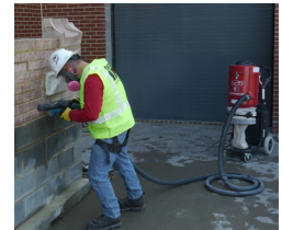
FOTO CORTESÍA DEL INSTITUTO INTERNACIONAL DE ALBAÑILERÍA
