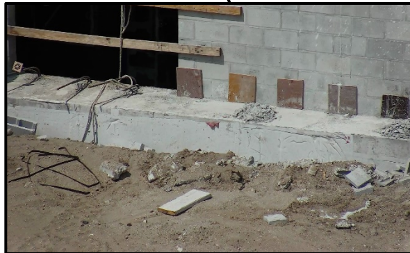
Tripping Hazard: Uneven site surfaces
