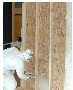
Figura 36. Estudiante de Job Corp utilizando una espuma en aerosol a base de soja.
