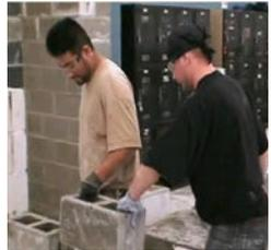
Aquí los trabajadores usan la técnica de emplear dos albañiles para levantar, lo cual reduce el estrés de levantar y torcerse.
