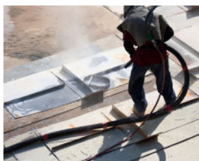
Un respirador con suministro de aire brinda un nivel alto de protección
