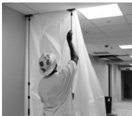
Trabajador que establece un área de contención durante una clase de entrenamiento de ICRA.
