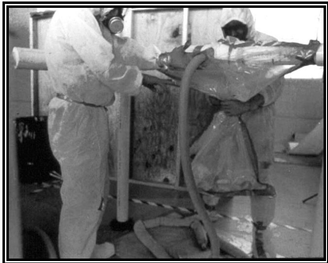
Quitando la bolsa-guante después de una reparación
