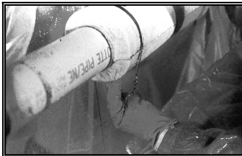
Uso de una sierra para quitar la cubierta de ACM de una tubería, en una bolsa-guante
