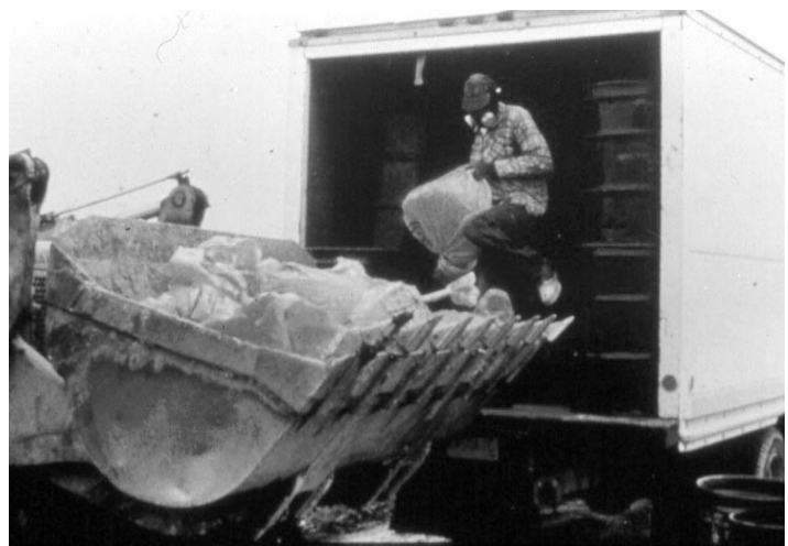
Descarga de residuos de ACM embolsados en un relleno sanitario aprobado por EPA.
