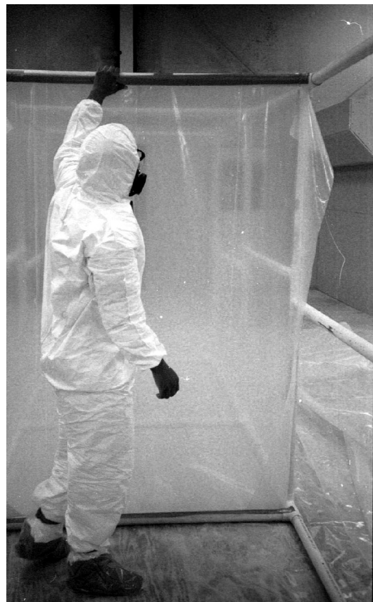
...una manera de construir un panel de puerta para la descontaminación...
