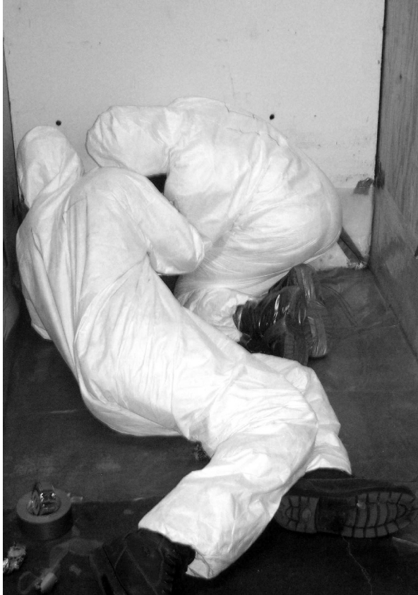
...cómo hacer “esquinas de hospital” al tender “poli” en el piso...
