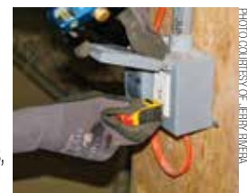
Evaluando un enchufe de GFCI para verificar que funciona apropiadamente.
